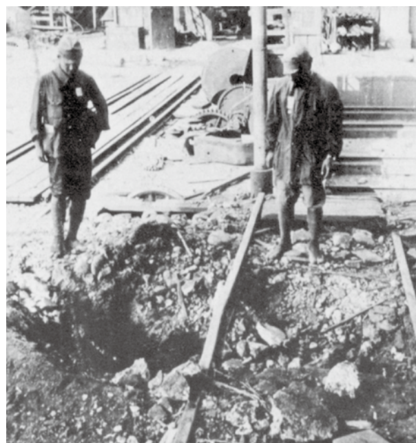
爆撃を受けた旧国鉄長野機関区（長野駅） （出典：長野が空襲された）
