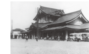
昭和11年に御開帳にあわせて建造された長野駅
